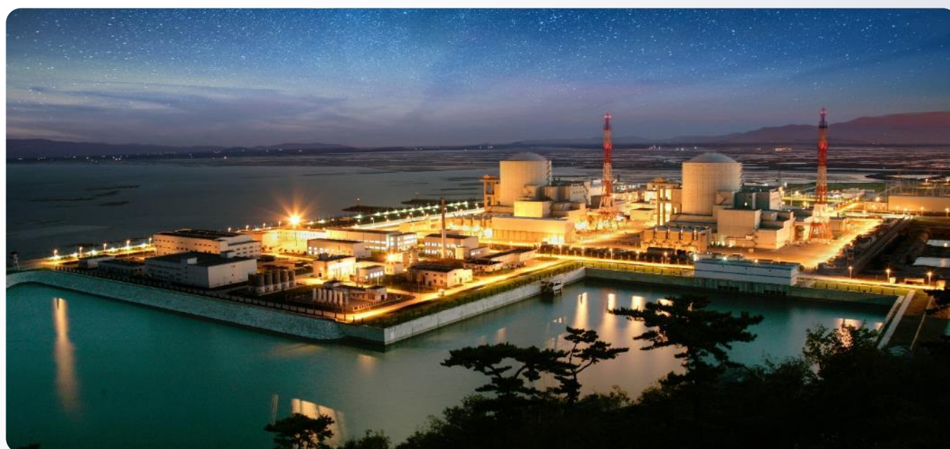
ДБЖ для атомної електростанції Tianwan
