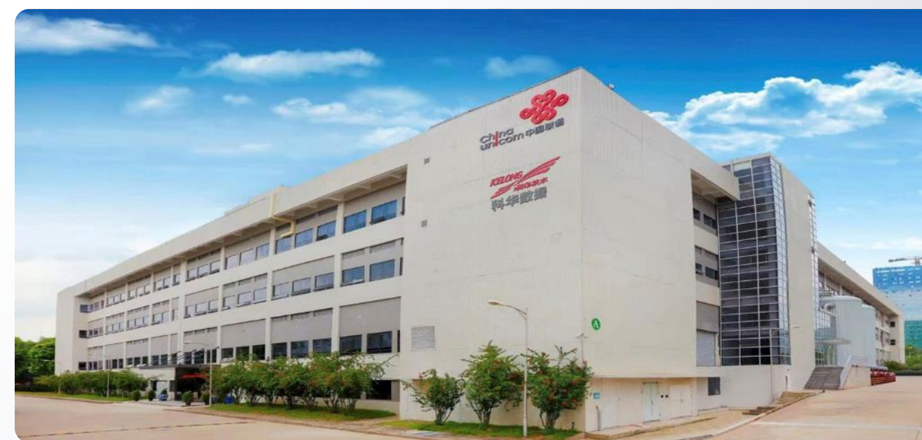
Дата центр Kehua Qiansheng в Шанхаї
