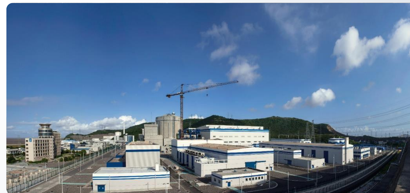
ДБЖ для атомної електростанції Fangchenggang
